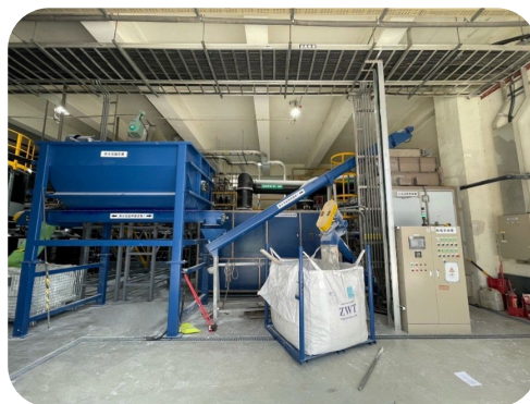
▲ 增設汙泥乾燥設備
