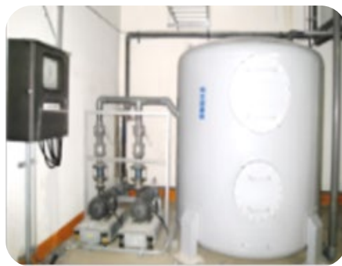
▲ 建置雨水回收系統
