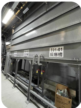
▲ 高硬度廢水去除系統
